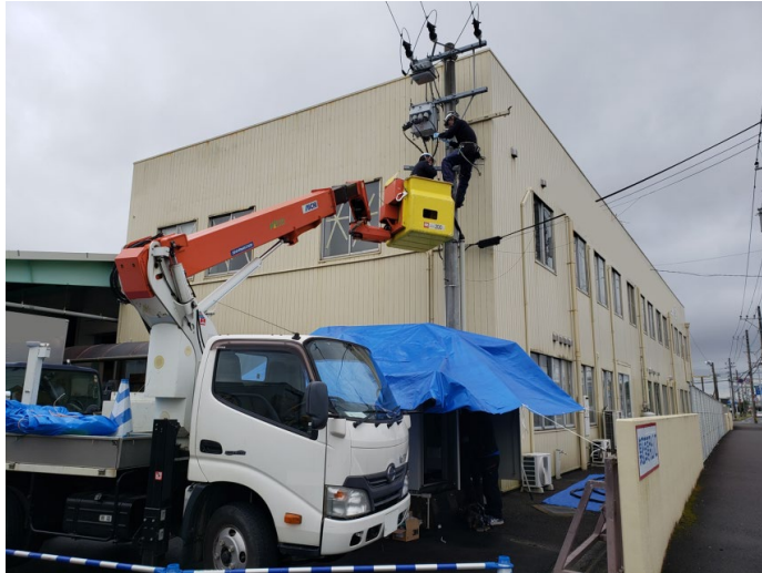
ケーブル更新状況
